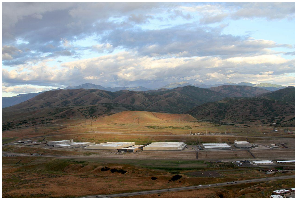
Abbildung 12: Utah Datacenter (Quelle: https://de.wikipedia.org )
